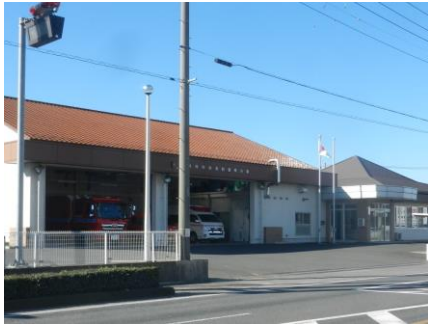
台風19号で浸水した東分署
