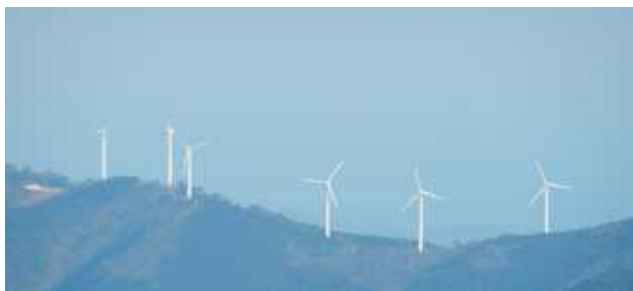
四国山脈の頂に並ぶ 高知県津野町の風力発電
